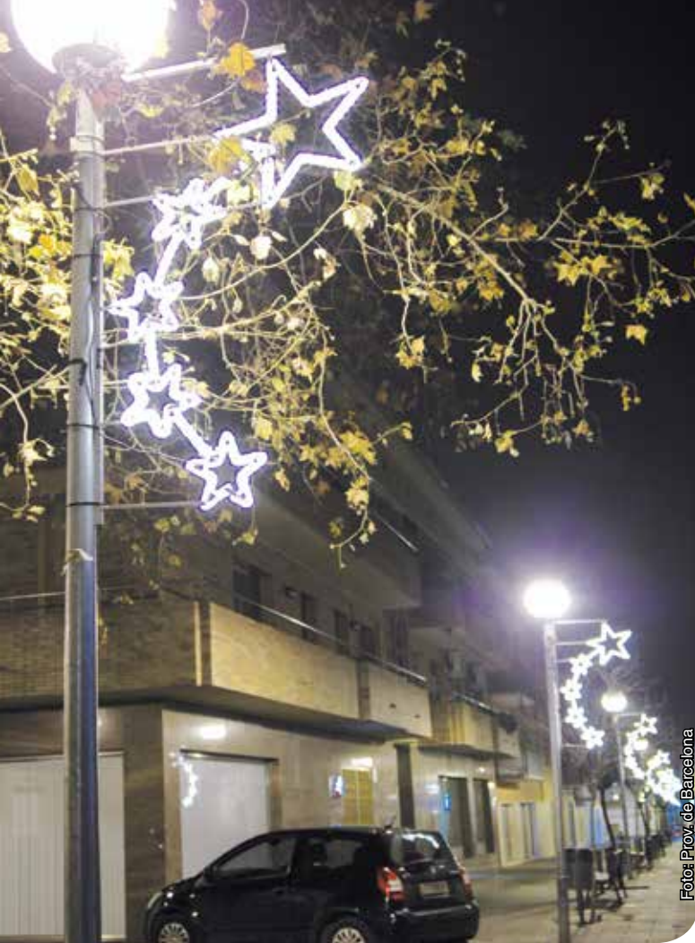
Montaje de "Osa Mayor" simple a farolas con su propia estructura Muntatge "d'Ossa Major" simple a fanal amb la seva pròpia estructura
